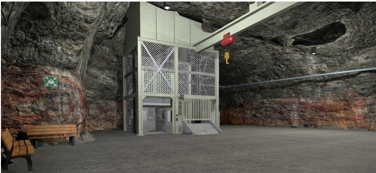
Abbildung 6 - Füllort und Wartebereich für Seilfahrt
