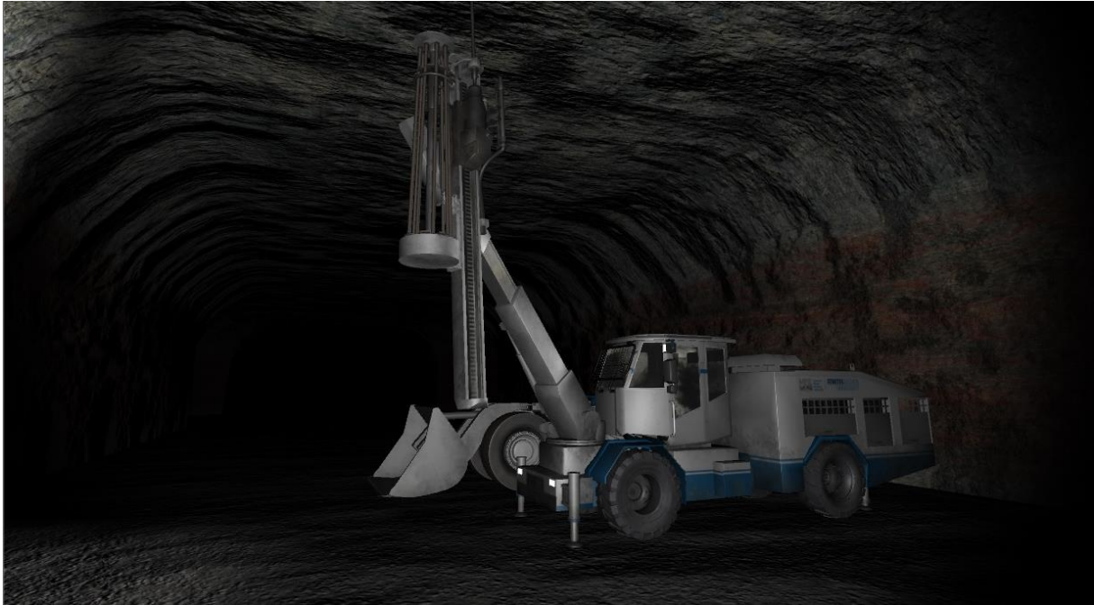
Abbildung 14 - Ankerbohrwagen beim Ankersetzen
